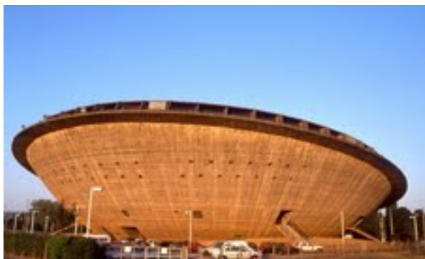
Fig. 3: L'affirmation: le palais des sports de Saint-Nazaire a été dénommé «la soucoupe».
