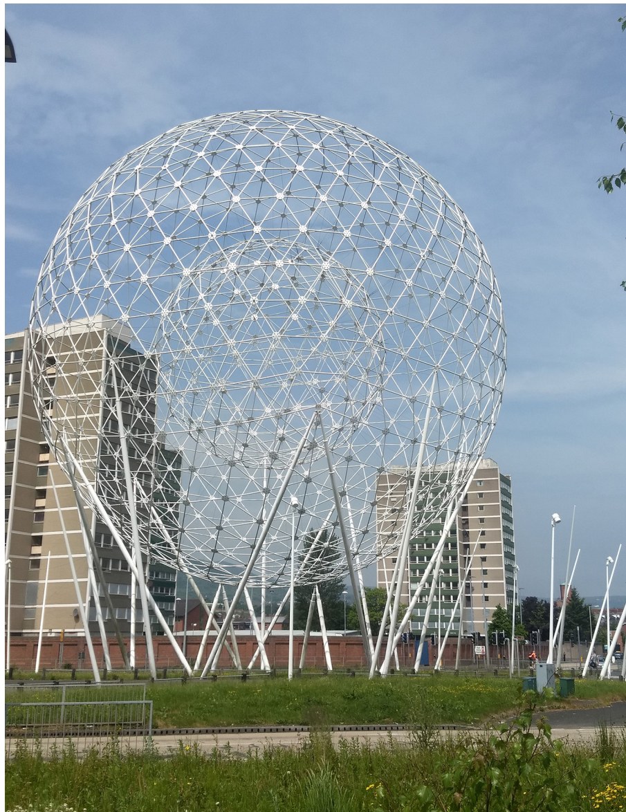
Figura 2. RISE (Wolfgang Buttress); acciaio, 37,5x30m, Belfast, Irlanda del Nord, 2011. Fotografia dell'autrice (2018)
